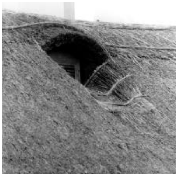
Eredeti, velence-tavi tetőablak félköríves nyílással, a párkány alatti nádköténnyel és szorítóléccel
