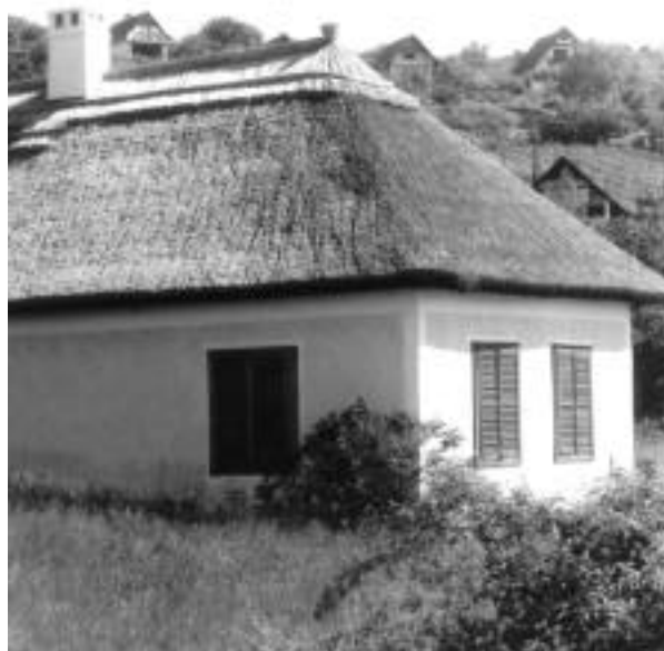
Sukorón található a fenti felújított épület, amely nagyon szép példája az ereszig kontyolt tetőknek.
