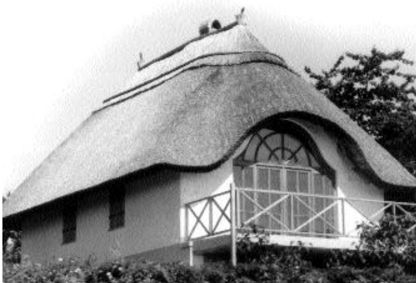
Hagyományos épület átépítéséből jött létre ez az üdülőépület a sukorói hegyoldalon. Szép példája a pozitív negatív görbületű tetőkialakításnak.
