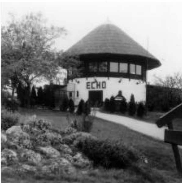
A tihanyi Vízhang épület fedése szép példája a klasszikus szélmalomfedés újraéledésének.
