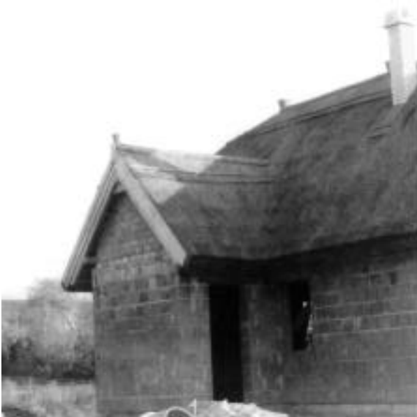
Épülő üdülőépület Velencén. Megfigyelhető a két nem azonos gerincmagasságú nyeregtető egymásba metszése, és a helyi hagyománytól eltérő oromdeszkás zárás.
